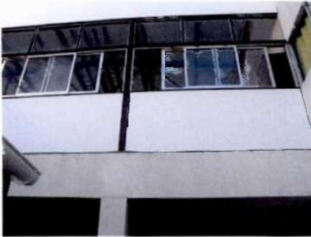
Fotografía N° 09: Vista de las ventanas instaladas en pasillo el segundo nivel del área técnico profesional del liceo
