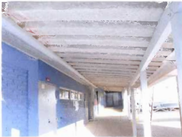
Fotografía N° 08: Detalle de la instalación de cubierta en sector de bodega, ejecutada con material reutilizado
