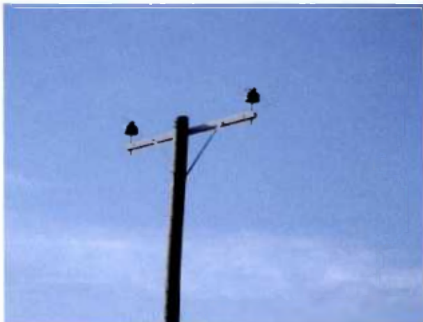
Fotografía N° 13: Vista de un poste de madera, emplazado en el tramo de la red donde se efectuó el hurto.
