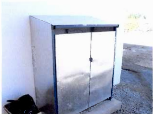
Fotografía N° 06: Detalle de la instalación de gas efectuada en el recinto de cocina del establecimiento educacional.
