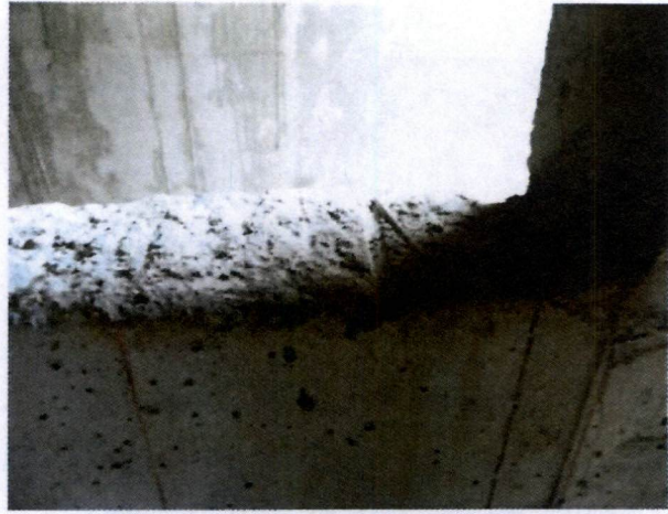
Fotografía N°50, de 28 de marzo de 2014: Eje R, entre ejes 11 y 13 de la Lámina Tipo A N°03, que contiene la Planta Piso -1 Nivel -3,00, Esc.1:100, de 12 de septiembre de 2012.
