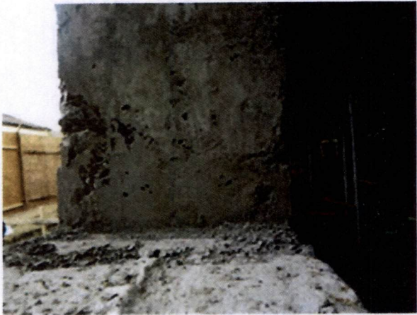
Fotografía N°3, de 28 de marzo de 2014: Borde interior oriente de vano que presenta nido de piedra en eje R, entre 7 y 8 de la Lam. A N°04 la Planta P.1 nivel 0,00, Esc.1:100, de 12 de septiembre de 2012.
