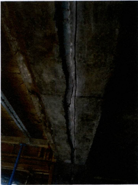
Fotografía N°15, de 14 de mayo de 2014: Vista de cadena ubicada entre los ejes Ñ-O y 8-9 de la Lam. A N°02 que contiene la Planta P.-2 Nivel -5,50, Esc. 1:100, de 12 de septiembre de 2012.
