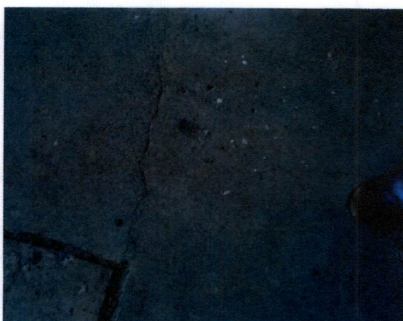
Fotografía N°55, de 8 de agosto de 2014: Entre ejes 7-8 y P-Q de la Lámina Tipo A N°05, que la Planta Piso 2 Nivel 3,00, Esc.1:100, de 12 de septiembre de 2012.
