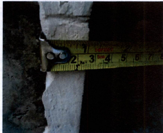
Fotografía N°40, de 14 de mayo de 2014, espesor de 2 cm. en muro sector surorientado de eje O, entre ejes 13 y 14 de la Lam. A N°03, que contiene la Planta Piso -1 Nivel -3,00, Esc. 1:100, de 12 de septiembre de 2012.
