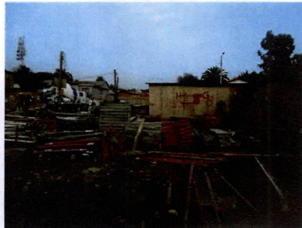
Fotografía N°61, de 24 de mayo de 2014: Vista del sector de instalaciones del personal de la obra.
