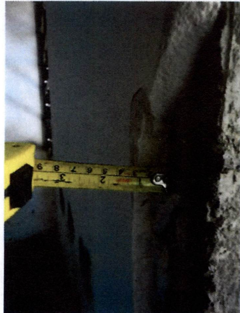
Fotografía N°46, de 8 de agosto de 2014: Ilustración que ilustra el excesivo espesor del recubrimiento del eje R.
