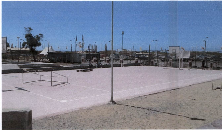
Fotografía N° 2: Vista de las obras ejecutadas.
