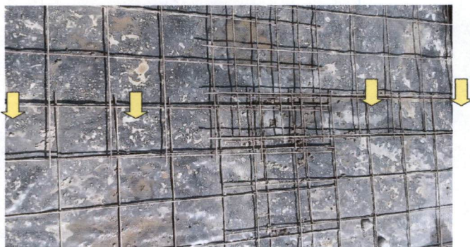
Fotografía N° 1: Detalle de traslazo utilizado, in situ, en mallas electro-soldadas
