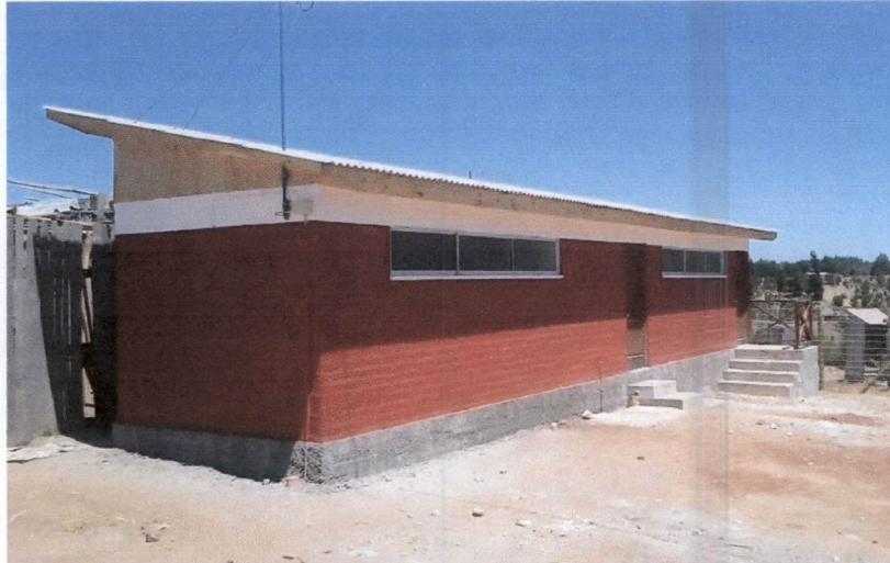
Fotografía N° 3: Vista de los camarines construidos.
