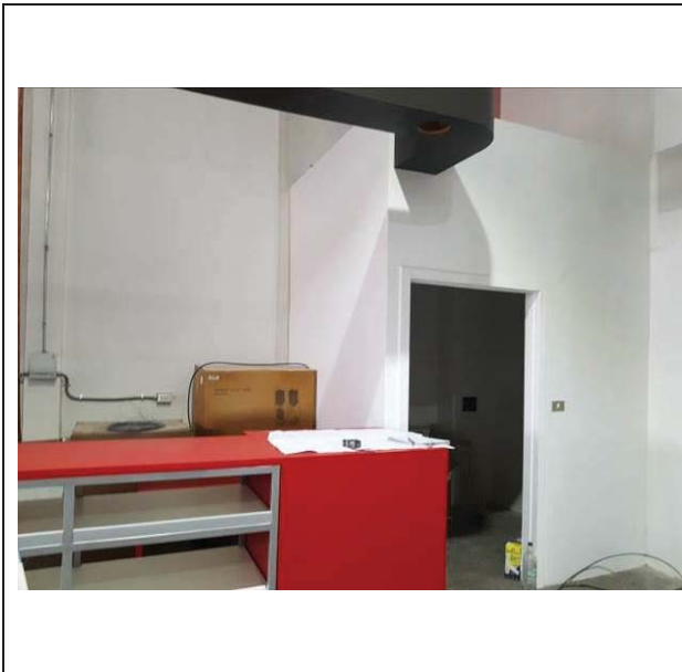
Fotografía N°10, de 11 de febrero de 2011: Vista frontal de la ejecución de un recinto destinado a servicios higiénicos, correspondientes al permiso de edificación N°11, de 2019.
