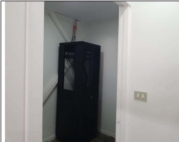
Fotografía N°14, de 11 de febrero de 2020: Acceso a recintos no informados en la planimetría del 2° nivel, del permiso de edificación N°11, de 2019
