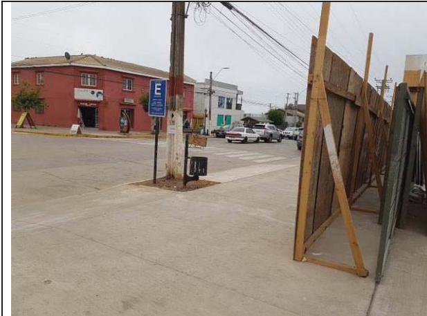
Fotografía N°8, de 11 de febrero de 2020: Vista lateral de los dos accesos construidos, para la construcción aprobada mediante el permiso de edificación N°11, de 2019.
