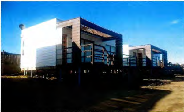
Fotografía N°9 -PE N°010/14, Camino sin nombre N°30, 5 cabañas de dos tipologías, que presentan modificaciones en su acceso y de superficie.
