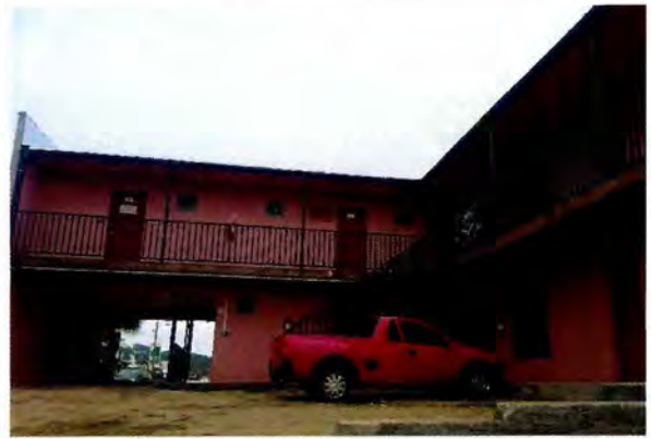
Fotografía N°16 -PE N°115/14, Ortuzar N°698, locales comerciales con modificaciones sin regularizar.
