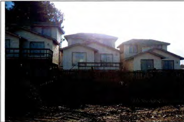
Fotografía N°1- PE N°38/14, Camino Cahuil N°1050, tercera vivienda se ejecutó con una superficies mayor a la proyectada.
