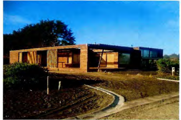
Fotografía N°8 -PE N°137/14, Camino Cáhuil N°4551, loteo de 15 construcciones, cabaña no concuerda con planos.
