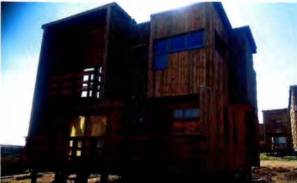
Fotografía N°11 -PE N°062/14, Suiza N°1220, 5 cabañas de dos tipologías, que presentan modificaciones en su acceso y de superficie.
