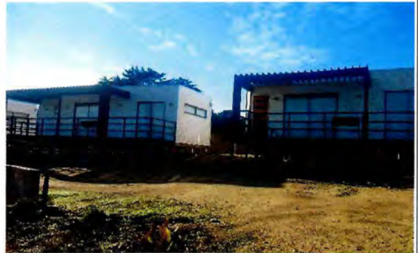
Fotografía N°10 -PE N°010/14, Camino sin nombre N°30, 5 cabañas de dos tipologías, que presentan modificaciones en su acceso y de superficie.
