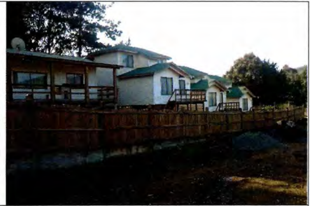
Fotografía N°2- PE N°38/14, Camino Cahuil N°1050, tercera vivienda se ejecutó con una superficies mayor a la proyectada.
